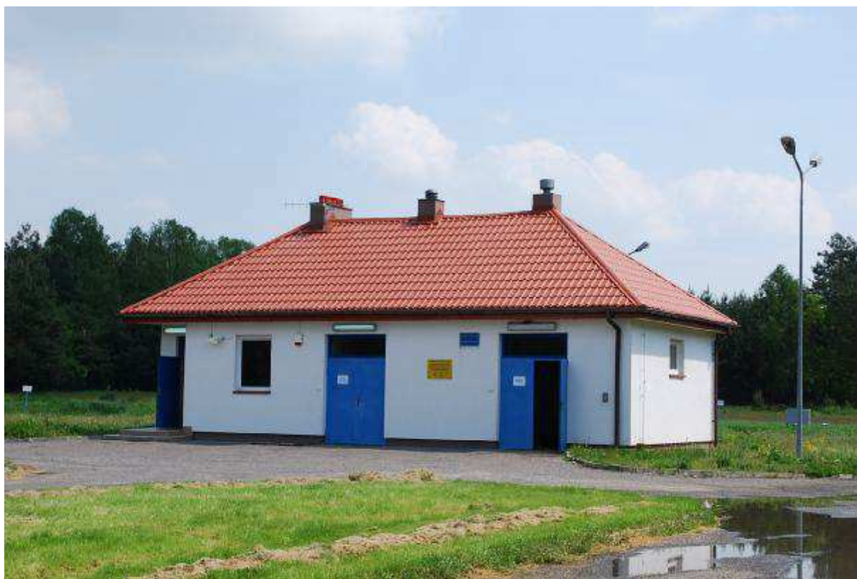
Budynek Oczyszczalni Ścieków w Rząśni gm. Rząśnia .
