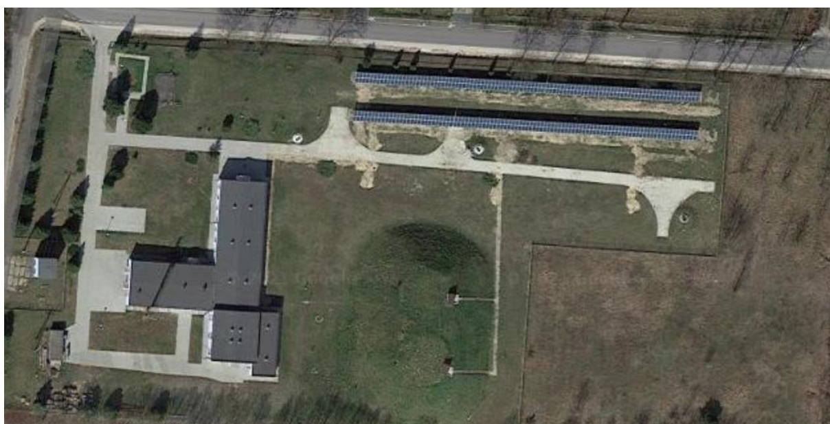
Rysunek 7 Farma fotowoltaiczna do zasilania Hydroforni w Rzaśni o mocy zainstalowanej 99,8 kW [ https://www.google.ru/maps ]
