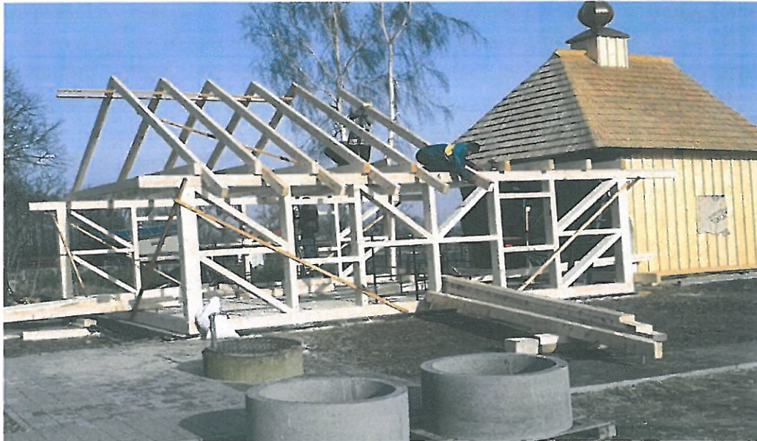
Zdjęcie wykonane w 2018 roku w trakcie trwających prac rozbudowy kaplicy.
